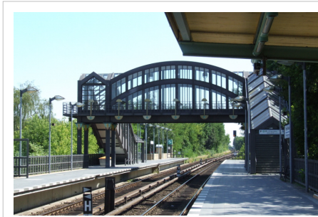
Übergang vom westlichen Bahnsteig zum Parkplatz
