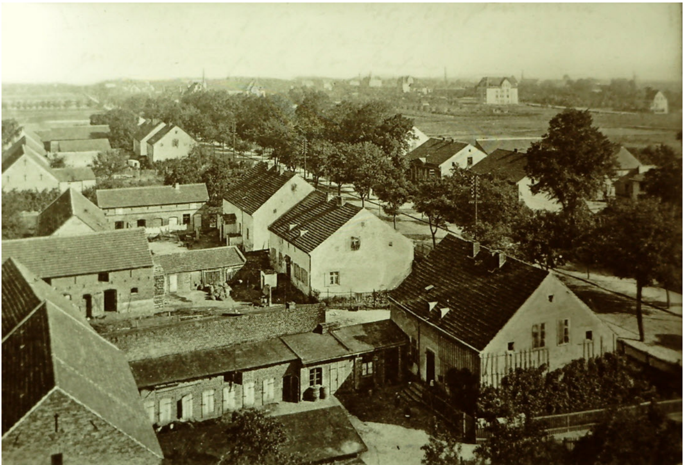
Blick vom großen Mietshaus nach Norden, um 1910
